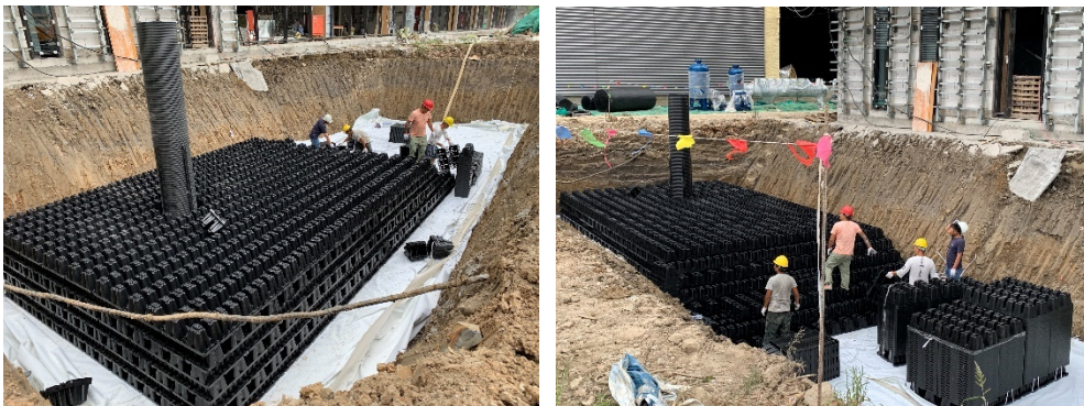
雨水回收系统建设现场
